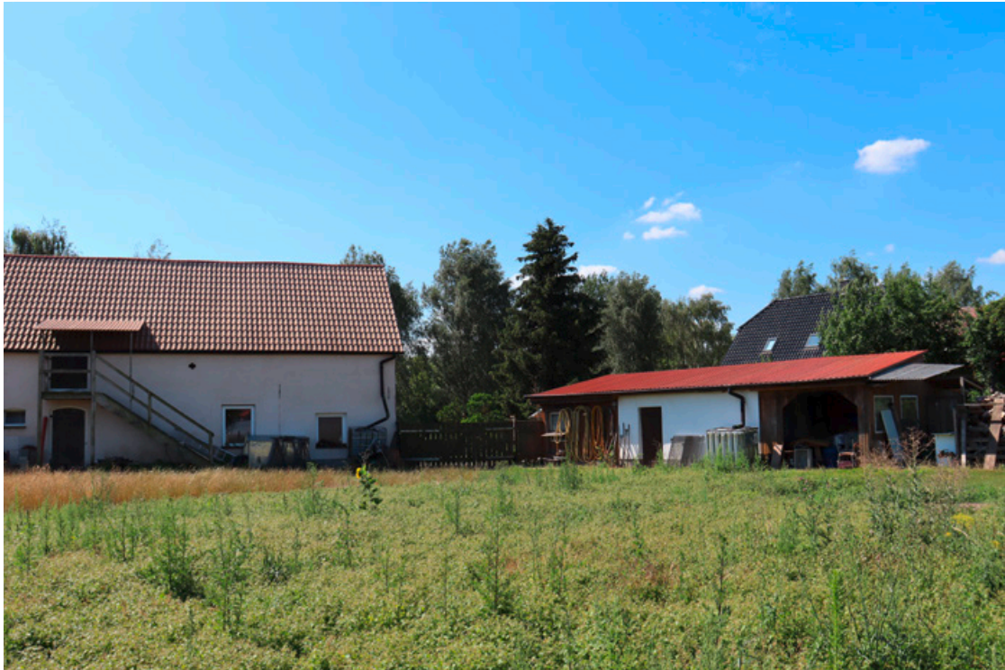
Blick von hinten auf Nebengebäude und Schuppen
