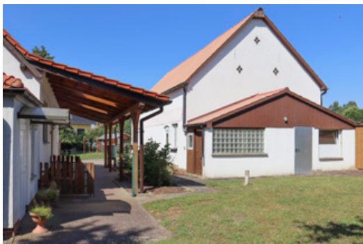
Nebengebäude mit viel Potential
